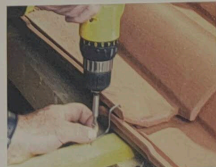
Fixation des tuiles en plain carré pour tenue au vent et à forte pente, par crochet "V2" Réf. CRV02.
