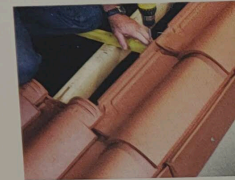
Fixation des tuiles en rive latérale droite par vis et rondelle d'étanchéité.
