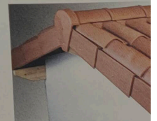
Fixation des rives individuelles et par vis et rondelle d'étanchéité.
