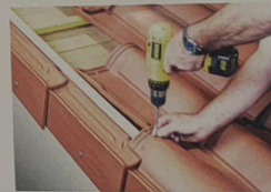
Fixation des 1/2 tuiles en rive latérale gauche par vis et rondelle d'étanchéité.
