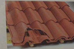
Pose du closoir d'égoût, fixé par la tuile du 1 er rang, par crochet V2 Réf. CRV02. (Le liteau ou le bandeau d'égoût n'est plus relevé pour éviter le basculement du 1 er rang de tuiles).
