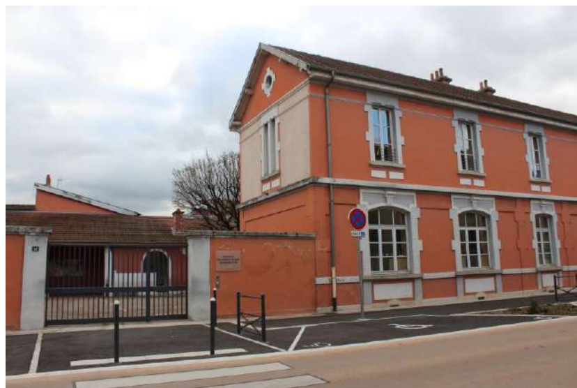
Travaux école élémentaire Gambetta
