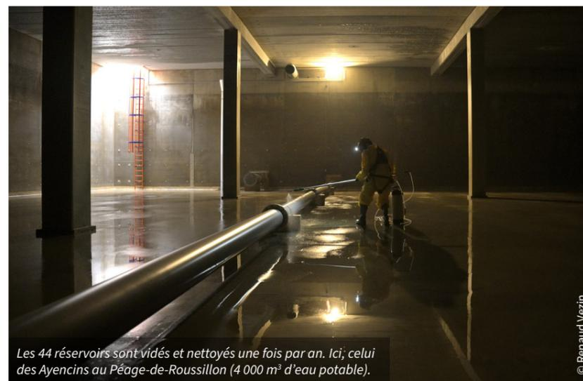
Les 44 réservoirs sont vidés et nettoyés une fois par an. Ici, celui des Ayencins au Péage-de-Roussillon (4 000 m³ d'eau potable).
