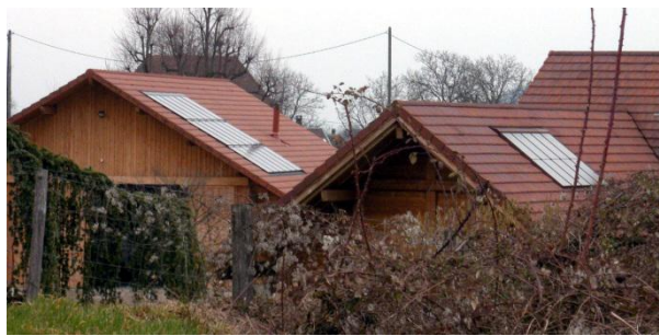
annexes avec toit terrasse capteurs bien intégrés, Commune de Virieu
