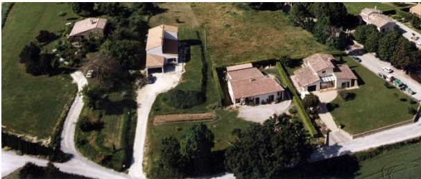
Eviter les voiries qui occupent l'espace du jardin. Un accès par le haut du terrain aurait pu dans ces cas limiter la part de la voirie sur le terrain.
