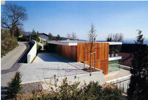
Bonne implantation dans la pente, accès direct de la voiture en haut de la construction, vue préservée. Suisse
