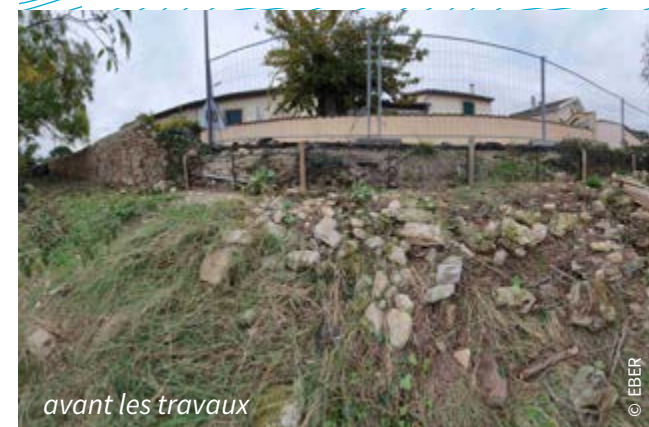
Mur de soutènement à Saint-Maurice-l'Exil
