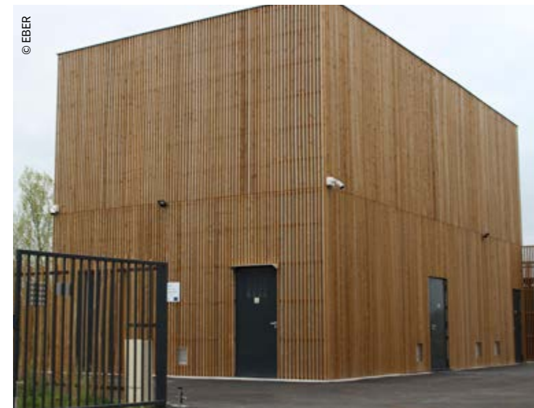
Poste de relevage à Saint-Maurice-l'Exil - le raccordement des eaux usées de l'ancienne station d'épuration de saint-Maurice-l'exil vers celle des Blâches a été réalisé au 1 er juin 2021.
